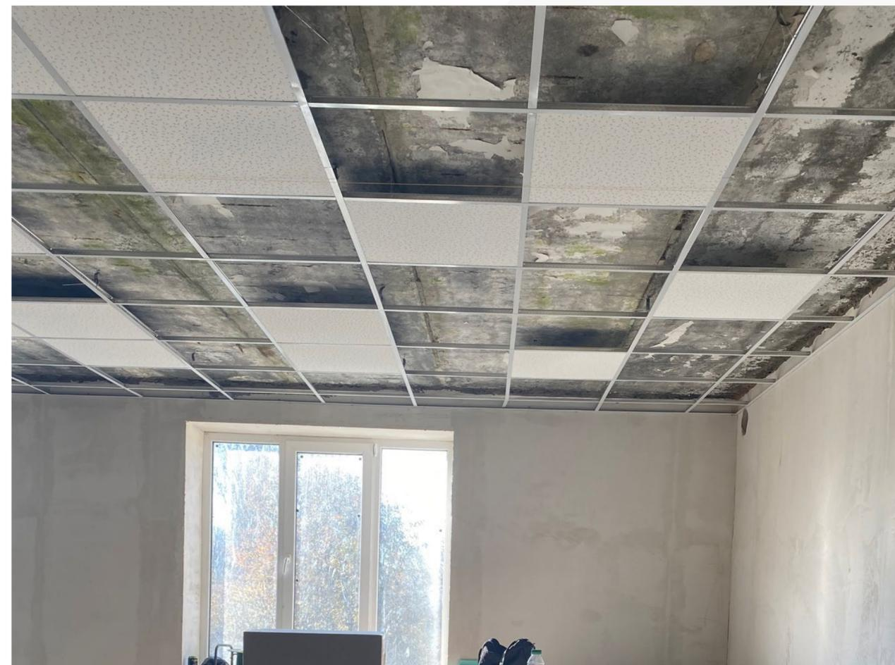
Локальные участки со следами биопоражения кладки стен и перекрытий не обработаны перед последующей чистовой отделкой.
