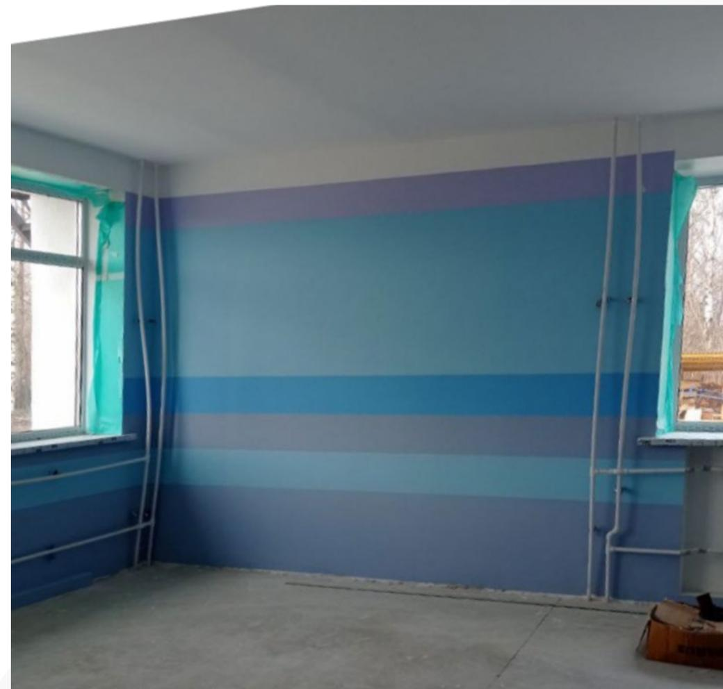
Стойки системы отопления имеют отклонение от горизонтальной оси, что
