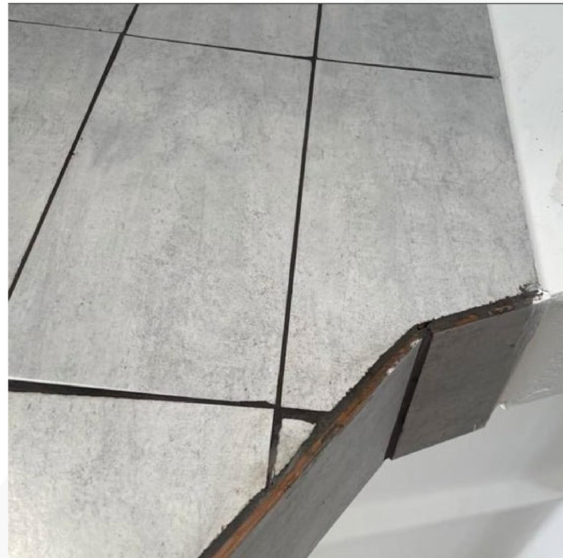
Низкое качество отделки - несостыковка швов, выпадение плитки из ряда, разная ширина межплиточного шва.
