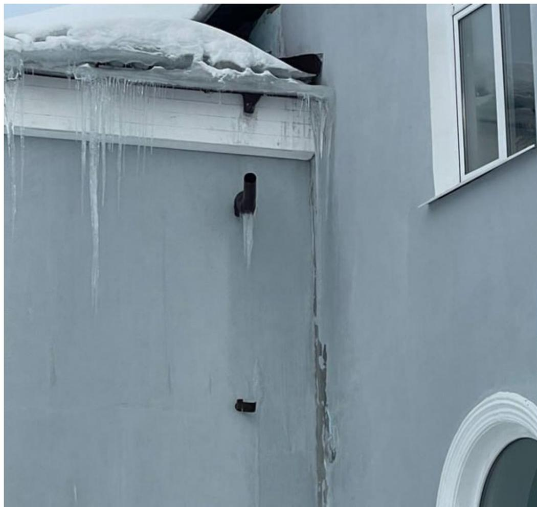
Отсутствует проектное решение сопряжение узла кровли и стены здания.
